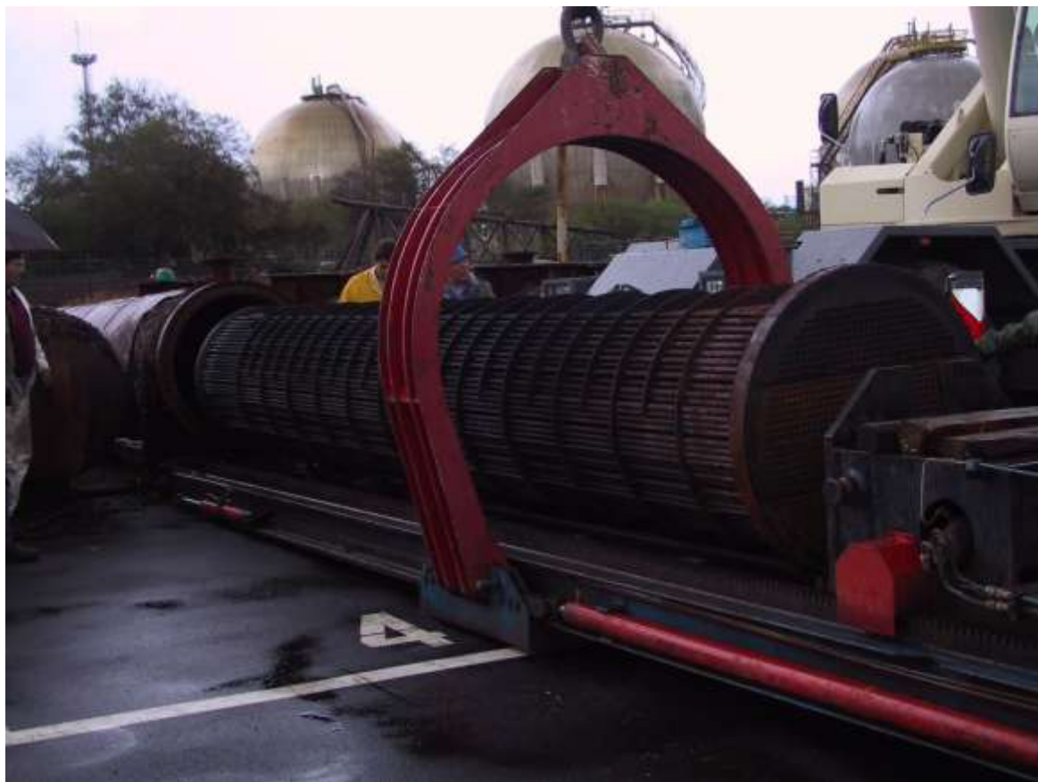
Figura 144: Fascio tubiero estratto da uno scambiatore di calore
