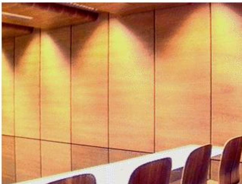
Figura 62: Esempio di membrana assorbente realizzata con pannelli in legno
