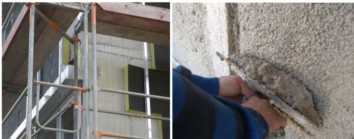
Figura 99: Applicazione dell'isolamento a cappotto e intonaco isolante
