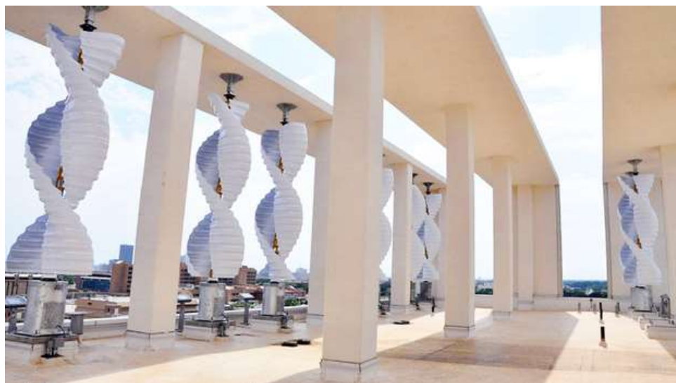
Figura 116: esempio di installazione di pale eoliche ad asse verticale, integrate alle strutture presenti su un terrazzo.
