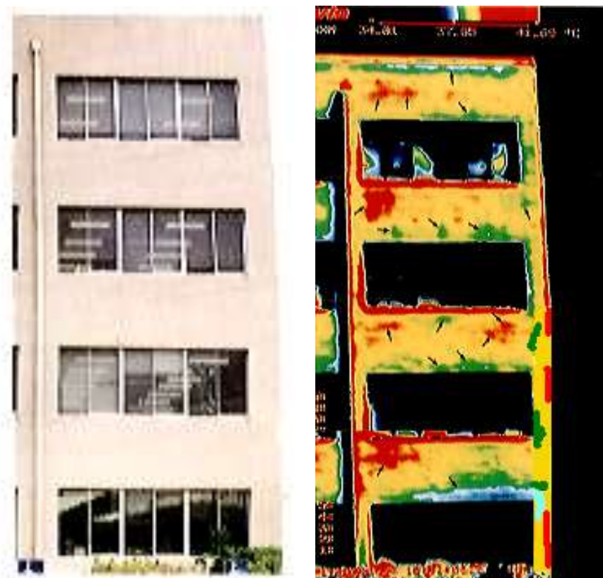
Figura 80: Termografia di una facciata
