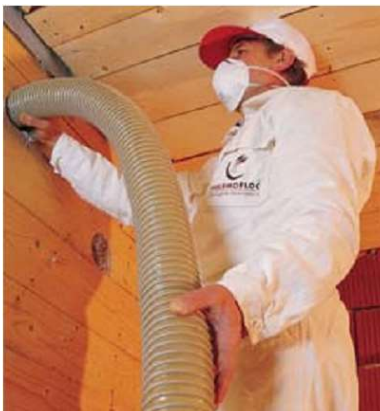
Figura 101: Inserimento di schiuma polimerizzante nell'intercapedine di una parete.
