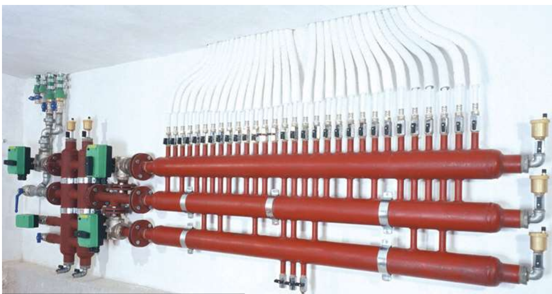
Figura 288: Esempi di collettori di centrale
