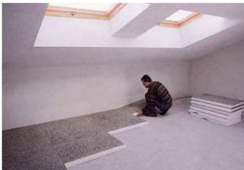
Figura 98: Posizionamento di isolante termico sulla copertura di sottotetto
