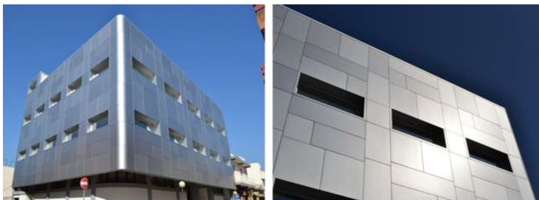
Figura 131: Viste dell'edificio post-intervento
