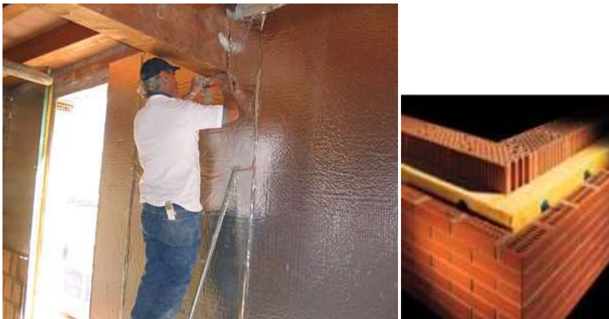
Figura 102: Applicazione di pannelli isolanti all'interno delle pareti
