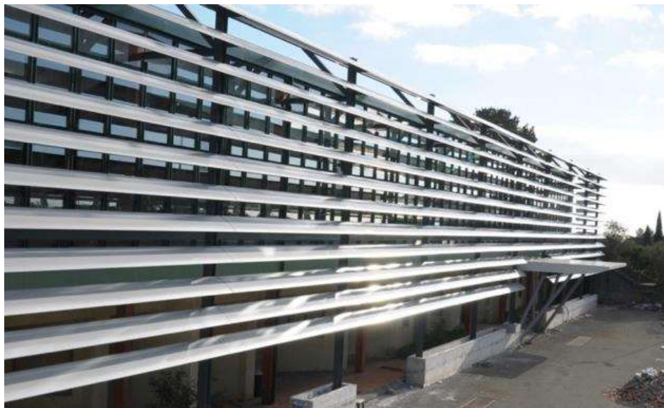
Figura 129: Esempio di schermatura esterna
