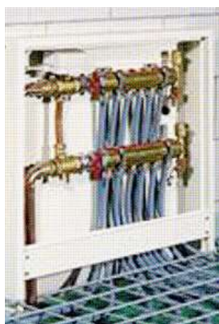
Figura 144: Coppia di collettori complanare di mandata e di ritorno
