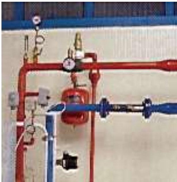
Figura 351: Foto esempio di installazione del vaso chiuso e della valvola di sicurezza
