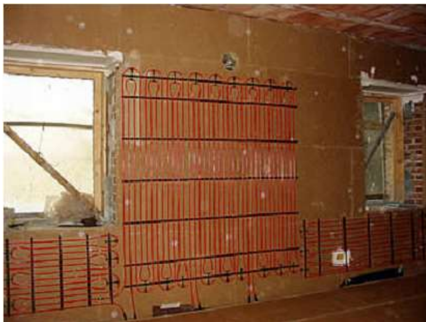
Figura 111: Inserimento di pannelli radianti a parete
