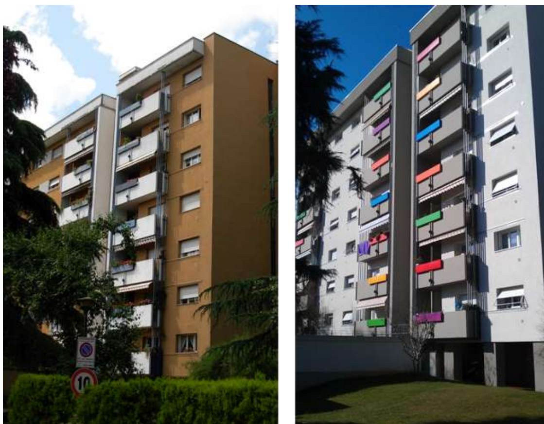
Figura 128: Esempio di inserimento di schermi mobili esterni
