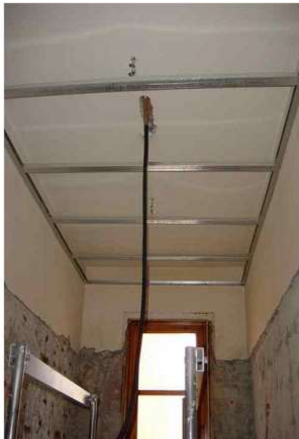
Figura 95: Controsoffitto interno a protezione dell'isolante
