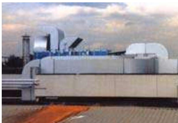
Figura 152: canali dell'aria posti fuori dall'edificio
