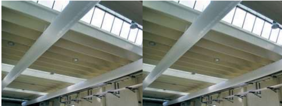
Figura 140: Distribuzione dell'aria con canali in tessuto
