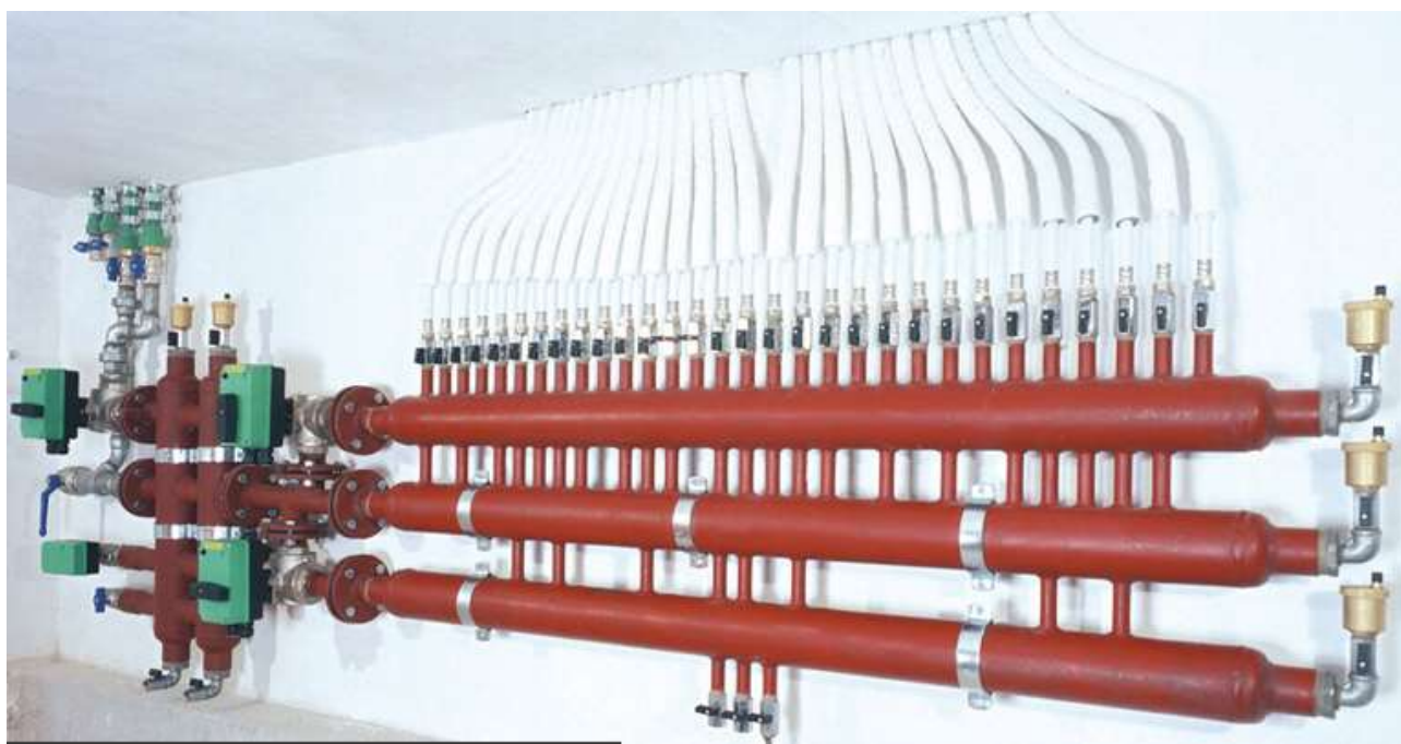
Figura 64: Esempi di collettori di centrale
